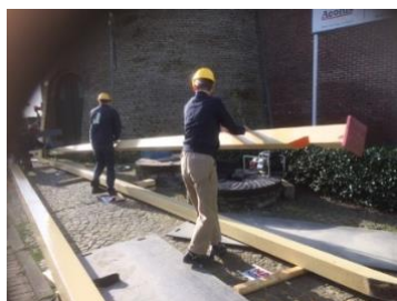
De twee nieuwe schoren liggen afgelakt en wel gereed voor montage
