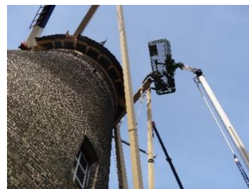
Plaatsing nieuwe schoor
